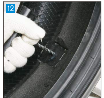
12 スパイラルリーマーに加硫剤を塗り内側から挿入し、傷穴の清掃と方向確認をする
